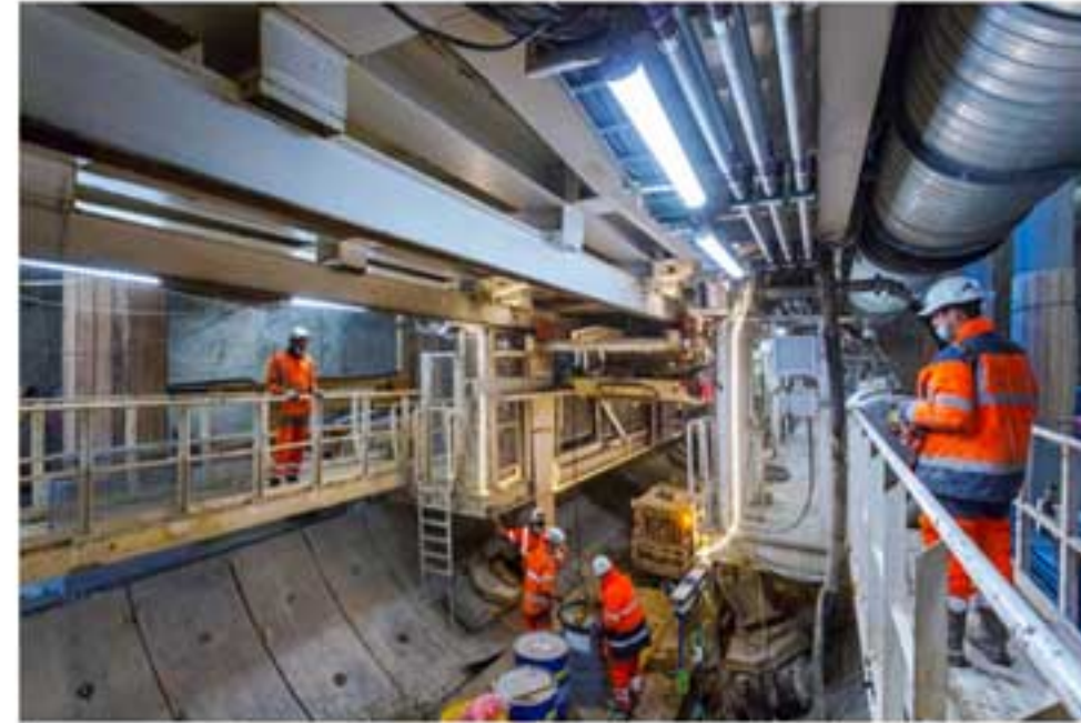
Die Gesamtlänge der Maschine mit vier Nachläufern beträgt rund 125 Meter.
