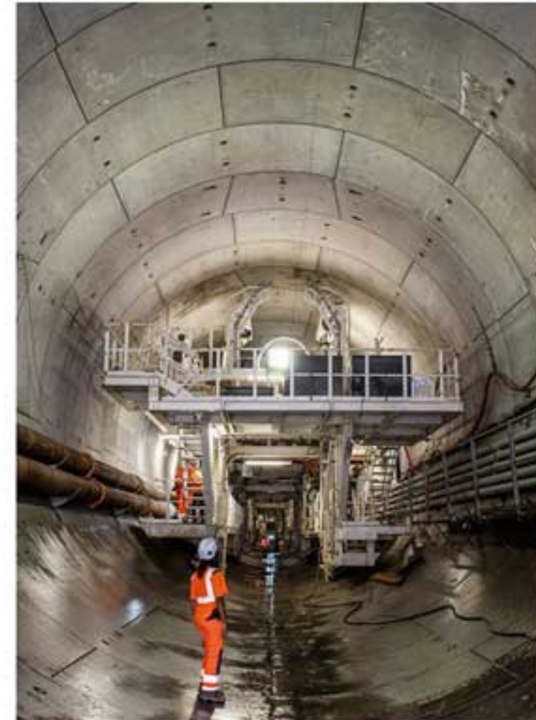
Die Mineure erreichten mit „Coline“ Wochenleistungen von bis zu 90 Meter gebohrtem und mit Tübbingem ausgebautem Tunnel.
